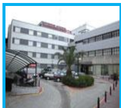
Hospital Quirón (Zaragoza)
